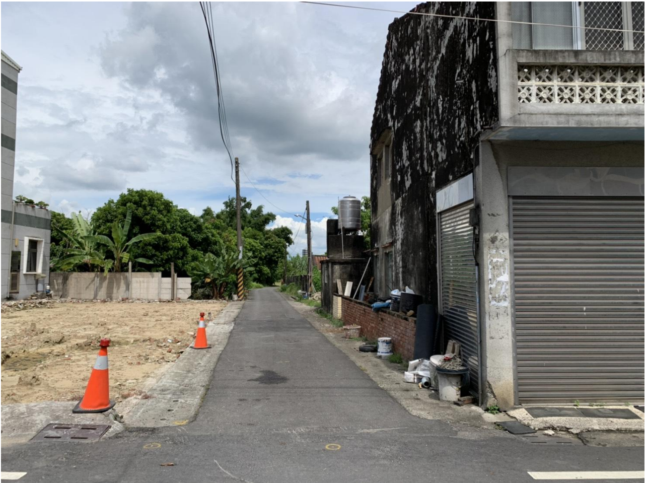
茄拔一小段 814-7 地號南側道路現況照片
